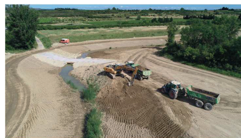
Travaux de suppression de digues défaillantes et renaturation du Briançon à Théziers (ci-dessus) - Prélèvement réalisé dans le cadre d'une étude sur les eaux souterraines (ci-contre)
